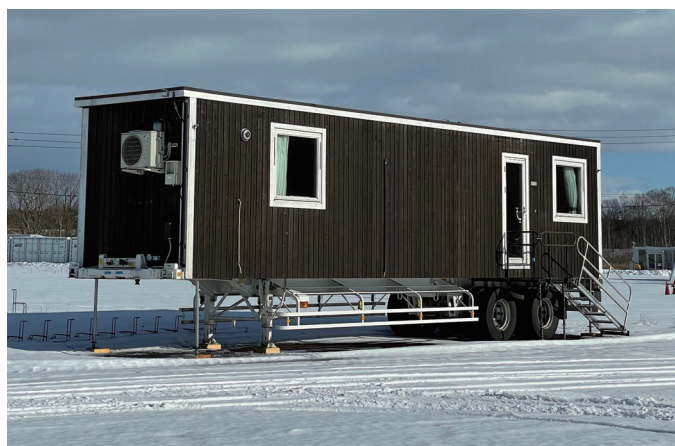
図1:キャンパスに設置したスマートモジュール
