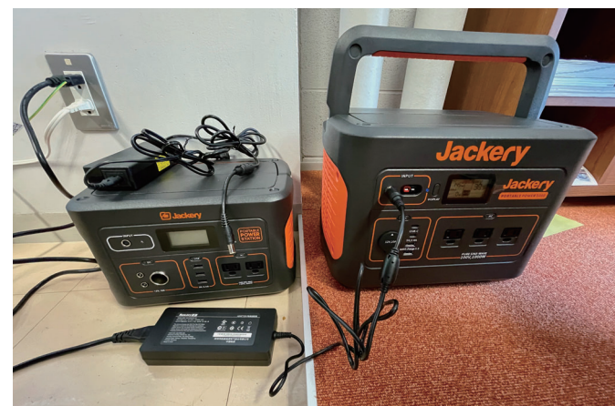
図3:実験に用いた蓄電池の例(左700W,右1000W)
