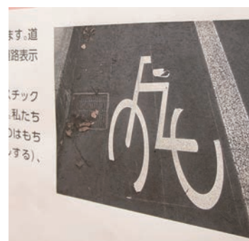
劣化した 道路標示の欠片
