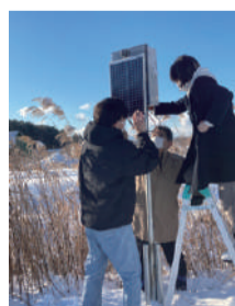
遠隔監視システムの構築作業の様子
